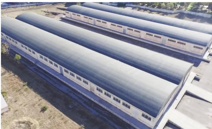
▲ *Fotografia aerea dei due corpi dell'ex deposito carburanti e la sua copertura a volta a botte ribassato. L'edificio, costruito nell'immediato ridosso della stazione ferroviaria, la forma estremamente allungata ed efficiente, le lunghe rampe di accesso sono tutti gli elementi che caratterizzano la vocazione infrastrutturale del complesso.*
